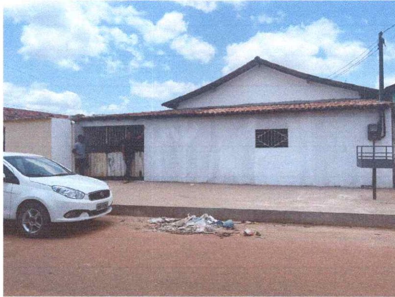
Figura 1 – Vista frontal da edificação
